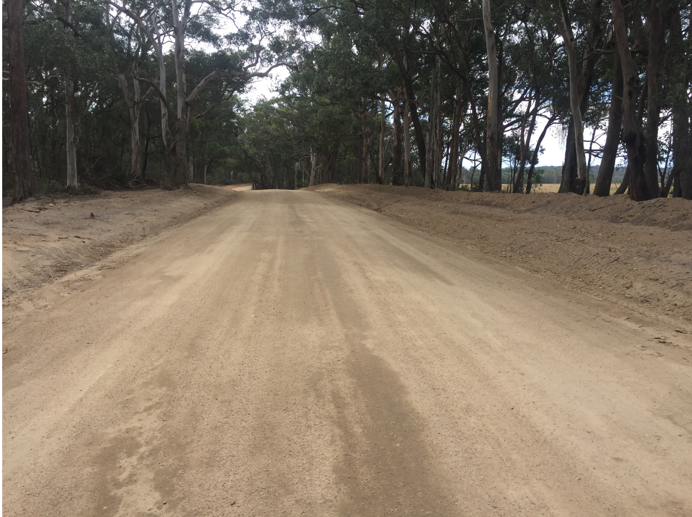
Resheeting Mt Lindesay Rd
